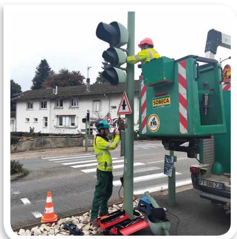
Remplacement des têtes de feux tricolores
