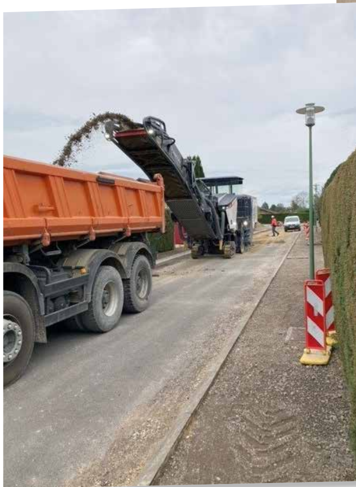
Travaux rue des Lilas
