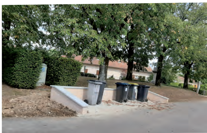
Construction plate-forme bacs à ordures au Carouge
