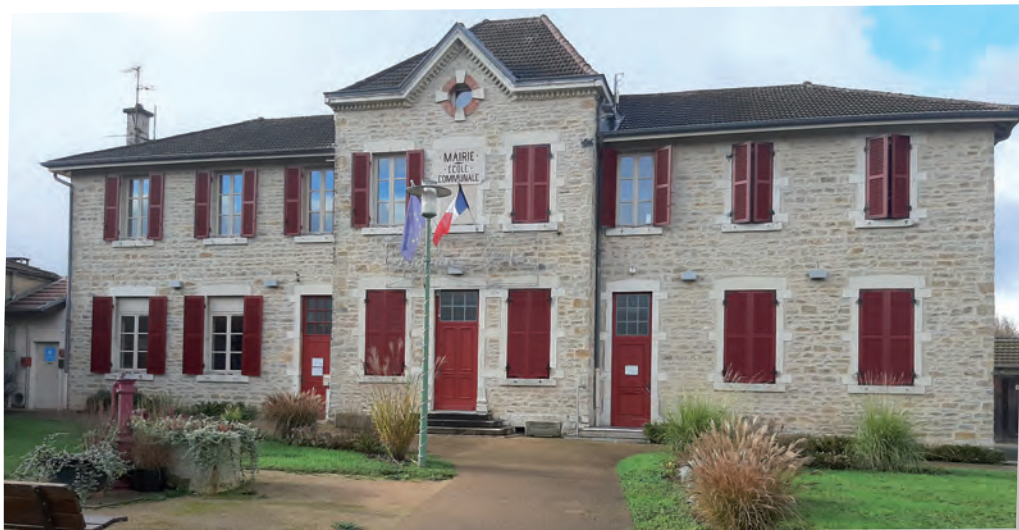
Remplacement des volets de la mairie, façade principale
